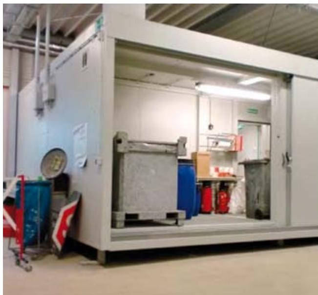
Bild 10-14a: Inhouse Gefahrstofflager
