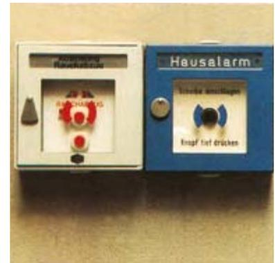
Bild 11-8: Druckknopfmelder für Hausalarm und zur Ansteuerung von Rauch- und Wärmeabzügen
