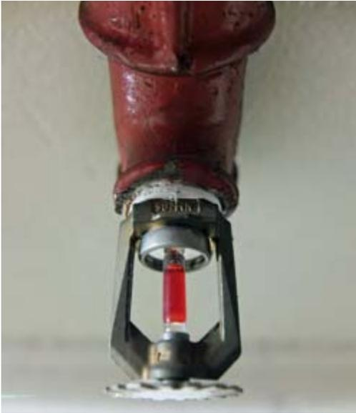
Bild 11-28: Sprinkler, Kennfarbe rot, Auslösetemperatur 68 °C
