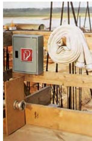
Bild 11-22: Feuerlöschgeräte auf einer Montagestelle
