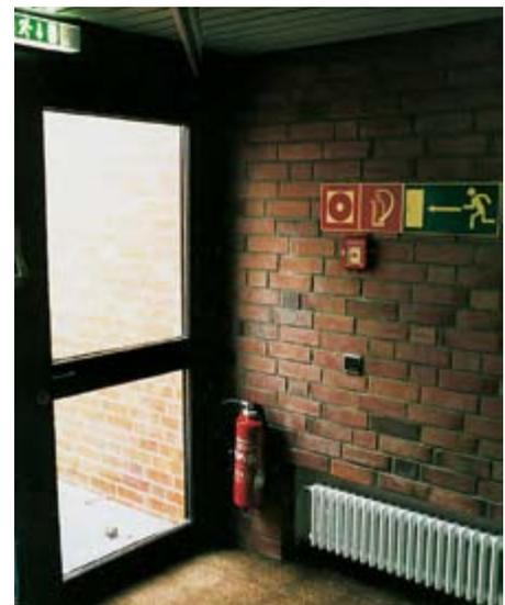
Bild 10-2: Notausgang in einem Verwaltungsgebäude mit Kennzeichnungen und Feuerlöscher
