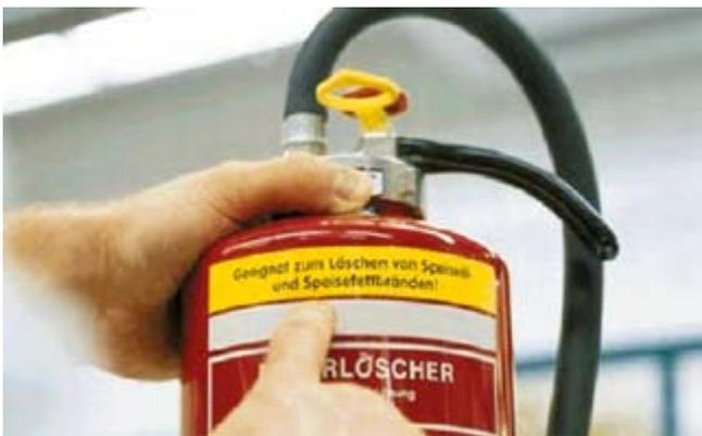
Bild 11-33: Feuerlöscher mit Kennzeichnung „Geeignet zum Löschen von Speiseöl- und Speisefettbränden“; Bild aus Report 3/2004 (Hotels und Gaststätten)
