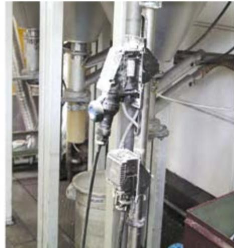
Bild 10-8: Elektrische Steckverbindung in explosionsgefährdetem Bereich
