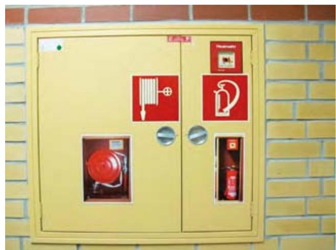
Bild 11-32: Wandhydrantenschrank mit Druckknopfmelder
