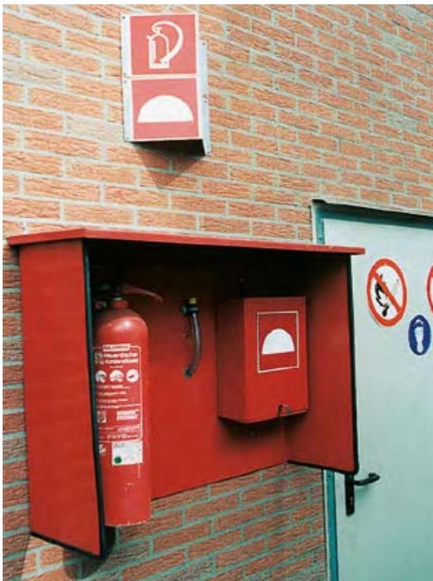
Bild 11-20: Feuerlöscher und Löschdecke im Betrieb
