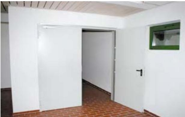
Bild 10-7: Feuerschutztür mit Schließfolge-Regelung
