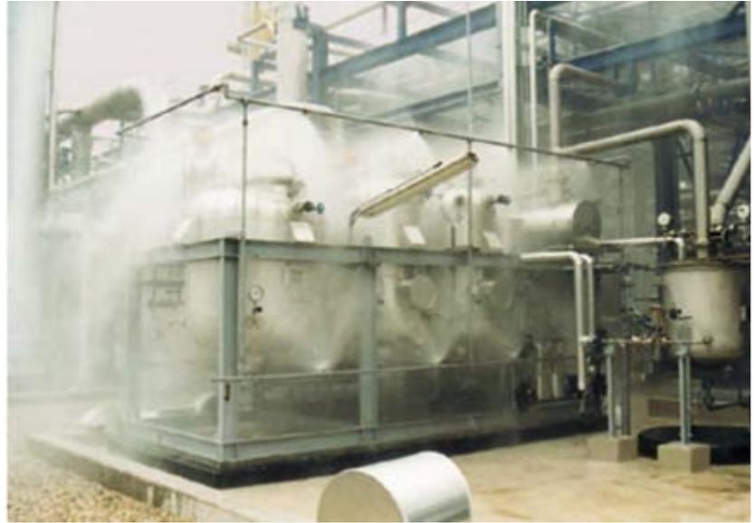
Bild 11-29: Einsatz einer Sprühwasserlöschanlage
