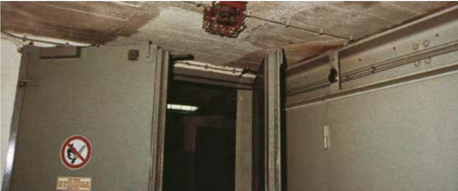
Bild 11-7: Meldergesteuertes Türmagnetsystem für selbstschließende Tür mit Schließfolgeeinrichtung als Brandabschluss für einen Raum zur Lagerung brennbarer Flüssigkeiten
